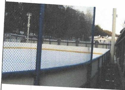
Ограждение из сетки рабицы, (рамка выполнена из профильной трубы, заполнение: оцинкованная сетка рабица, размер ячейки 45x45мм, толщина проволоки 2мм) Стоимость 1 150 000 руб. (предварительный расчет)
