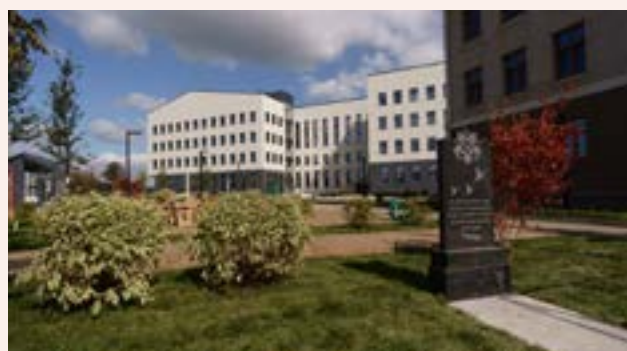
Школа №1 им. М.К. Тагирова, Альметьевск, произведены капитальный ремонт и реконструкция
